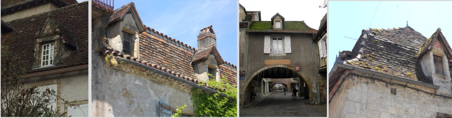
Exemples de lucarnes en pierre à fronton. A noter le premier exemple particulièrement remarquable de lucarne à fronton mouluré du XVIIème siècle. Dans le dernier exemple, la lucarne est dite passante car elle interrompt l'égout de la toiture.
