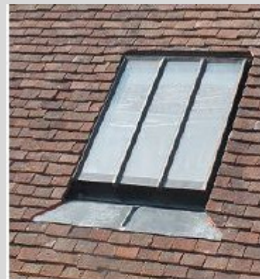
Exemple de châssis de toiture en fonte recoupés par un ou deux meneaux
